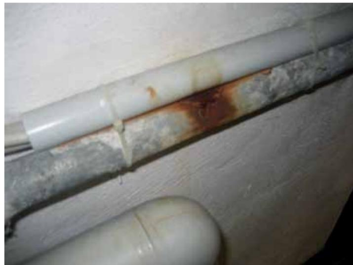
Gasleitung, die inklusive Schutzrohr durchbohrt wurde.
