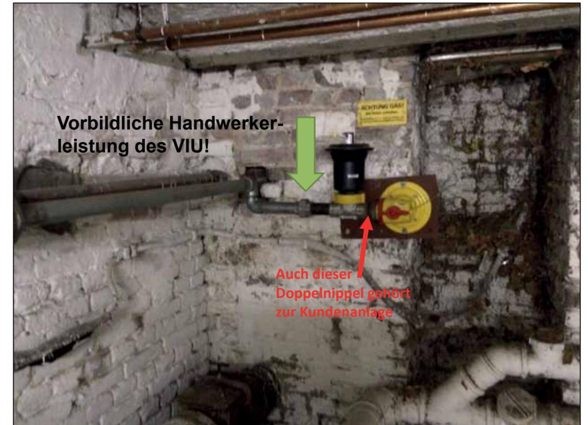
Dem Netzbetreiber gehören die Gasleitung von der Versorgungsleitung bis zur HAE, ggf. noch eine Absperreinrichtung vorm Haus, das Isolierstück und die HAE, weiter der Druckregler und der Gaszähler!
